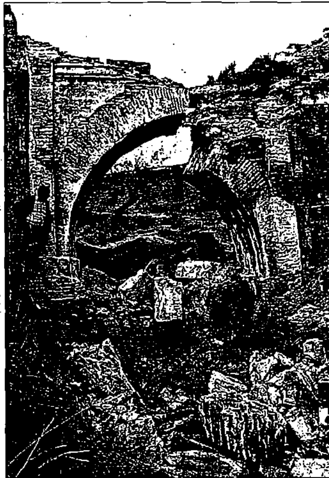
El Acueducto de San Telmo también ha sufrido las consecuencias de las últimas lluvias y un corrimiento de tierra provocó el desprendimiento de un arco de una de las obras hidráulicas más importantes del siglo XVIII que se han construido en España. Las lluvias hicieron que el arco finalmente se derrumbara
