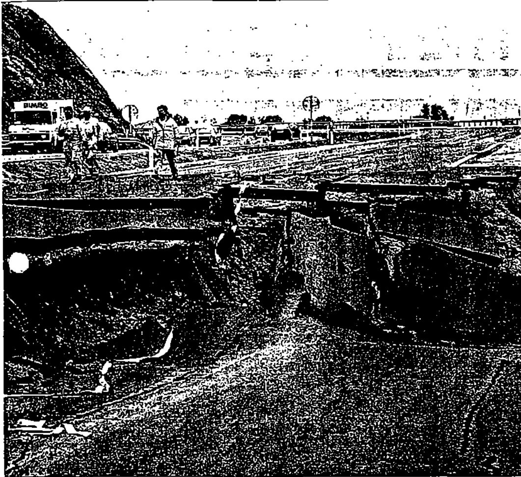
La Ronda Este sufrió un espectacular hundimiento de unos cien metros a la altura del falso túnel de San José, al desplazarse el terraplén que la soportaba. El tráfico permanece cortado en los carriles afectados y las obras para su reparación se prolongarán durante un mes como máximo, según el director general de Carreteras, Juan Francisco Lazzano
